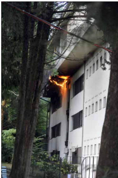
Slika 9: Zapadna strana zgrade, razvoj požara po vertikali
